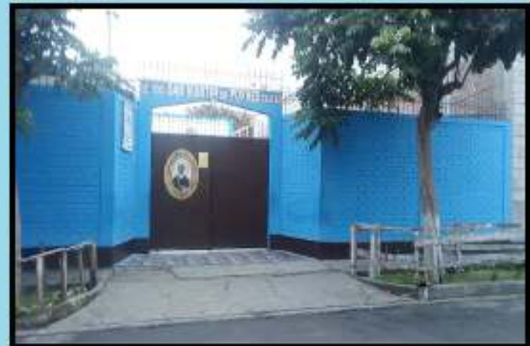
I.E 5083 SAN MARTIN DE PORRES – DESPUÉS
